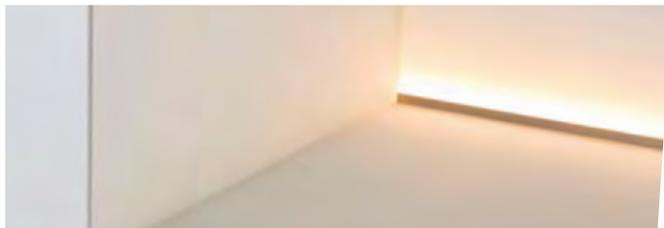
Die Lichteinspeisung erfolgt von unten in die Glaskante. Dort bündelt sich das Licht und läßt die auf der Arbeitsplatte stehenden Gegenstände „wie in einem anderen Licht“ erscheinen.
