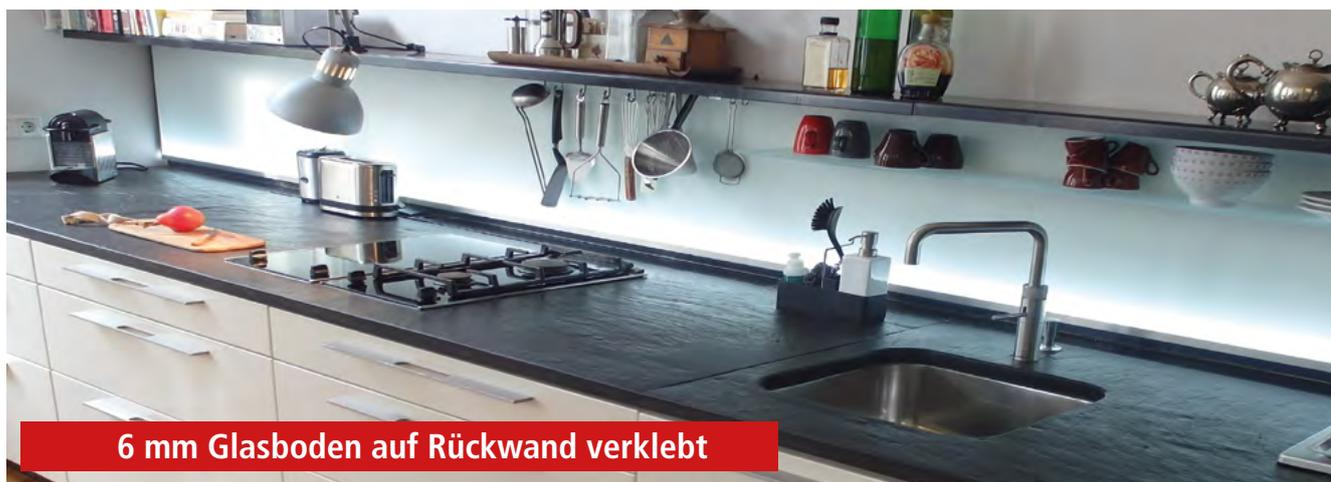
UV-Verklebung für die unsichtbare Konstruktion von Glasregalböden ab 6 mm Glasstärke für starke Gewichtsbelastung. Theken mit Glasstandfuß, Tische mit Glasfußgestellen, Regale und Hängeschränke sind die Einsatzbereiche der UV-Verklebung bei Glas.
