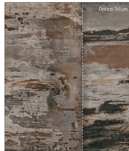
Farbunterschiede im Plattenstoß
